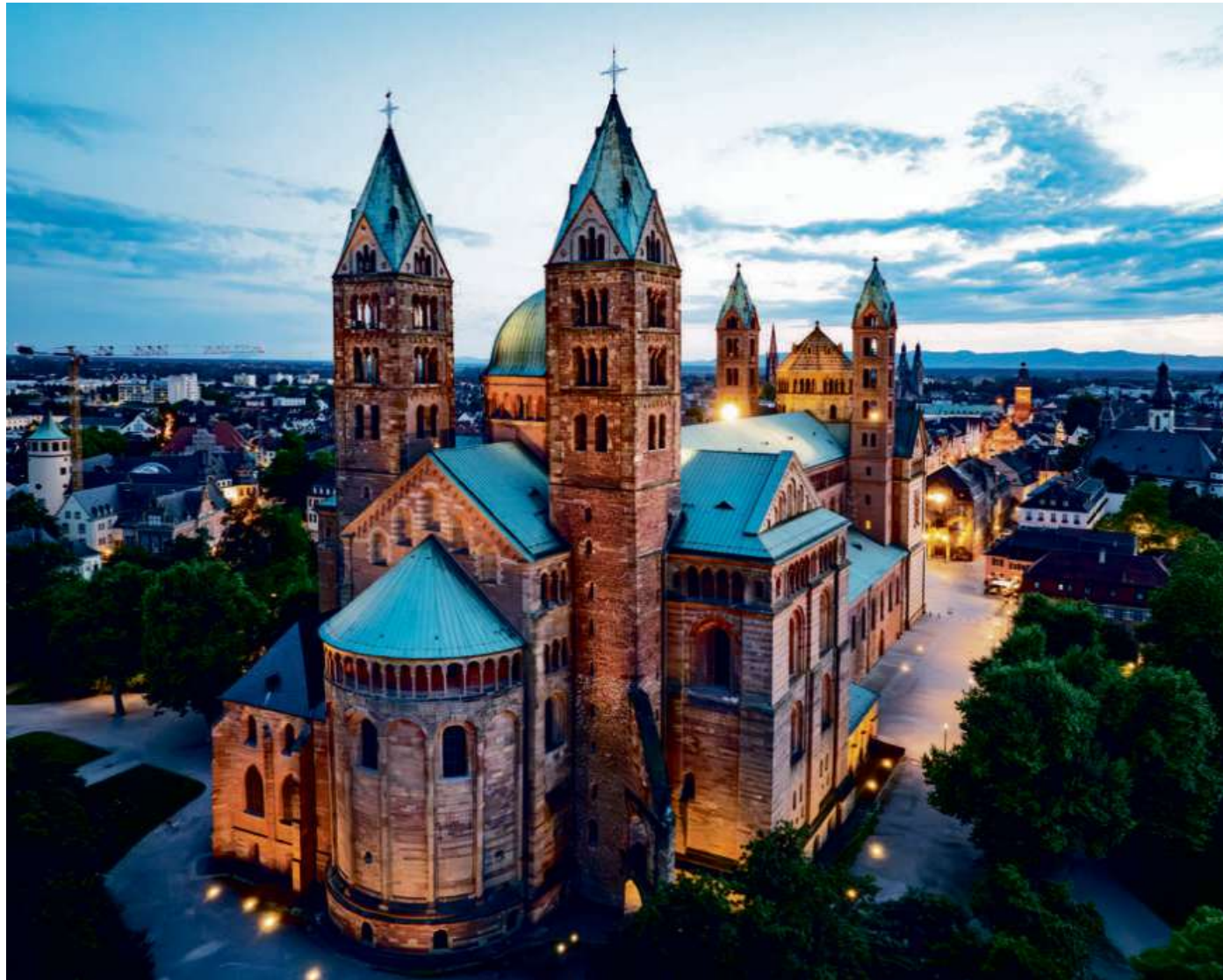
Das wird es lange nicht mehr geben: Gesamtansicht des Doms ohne Gerüste.
