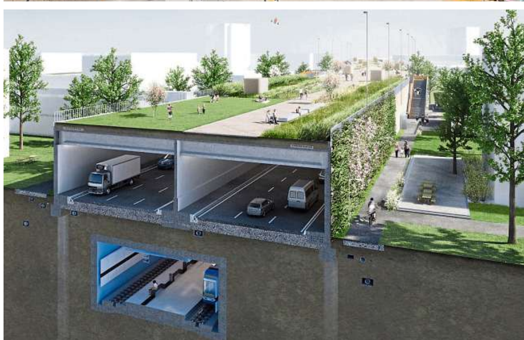
Die Einhausung der sechsspurigen Autobahn in Zürich-Schwamendingen wurde in diesem Jahr fertiggestellt. Auf dem Überlandpark können Fußgänger flanieren, darunter verläuft die sechsspurige Autobahn A1L und ganz unten fährt die Tram. Fotos: Marcel Benedikt; Bundesamt für Strassen ASTRA
