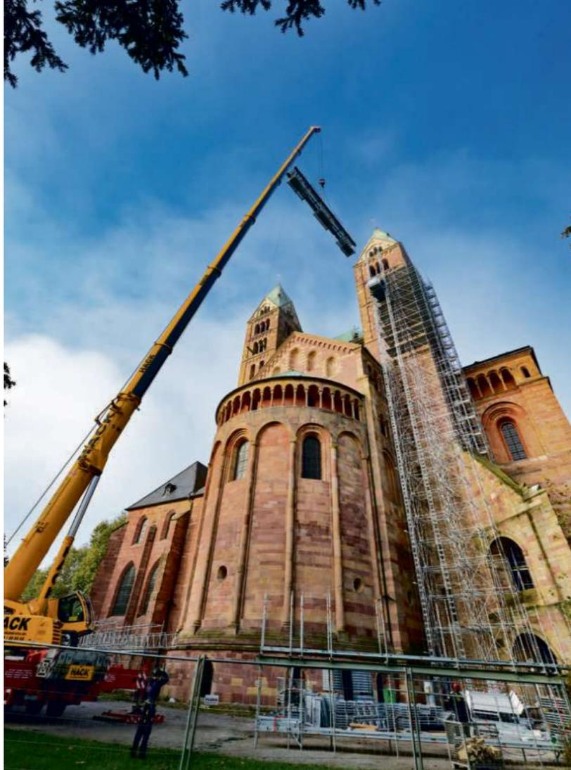
Ein Teleskopkran transportiert vormontierte Gerüstteile zum Bestimmungsort am Südostturm des Doms.
