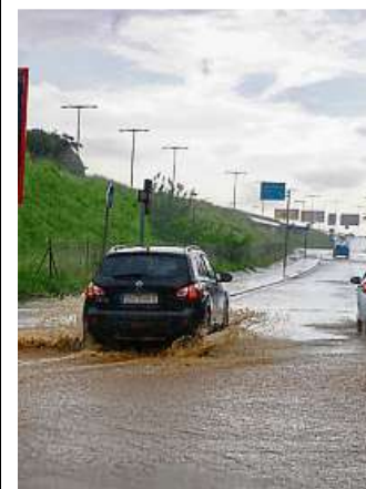
Autos fahren in Badalona bei Barcelona auf einer Straße, die nach schweren Regenfällen überflutet ist. Foto: dpa
