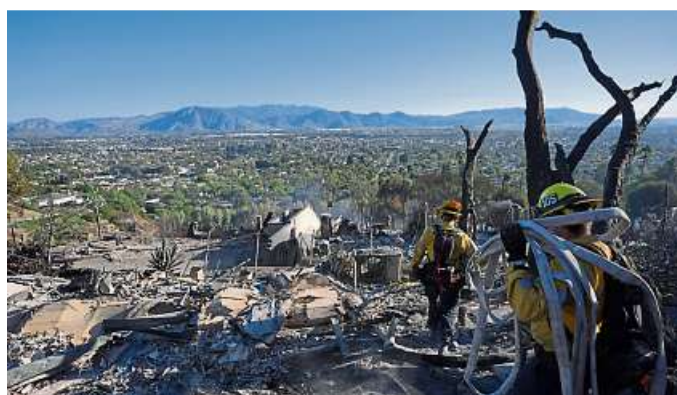
Feuerwehrleute arbeiten in einem vom Mountain Fire zerstörten Haus in Camarillo, Kalifornien. Foto: dpa
