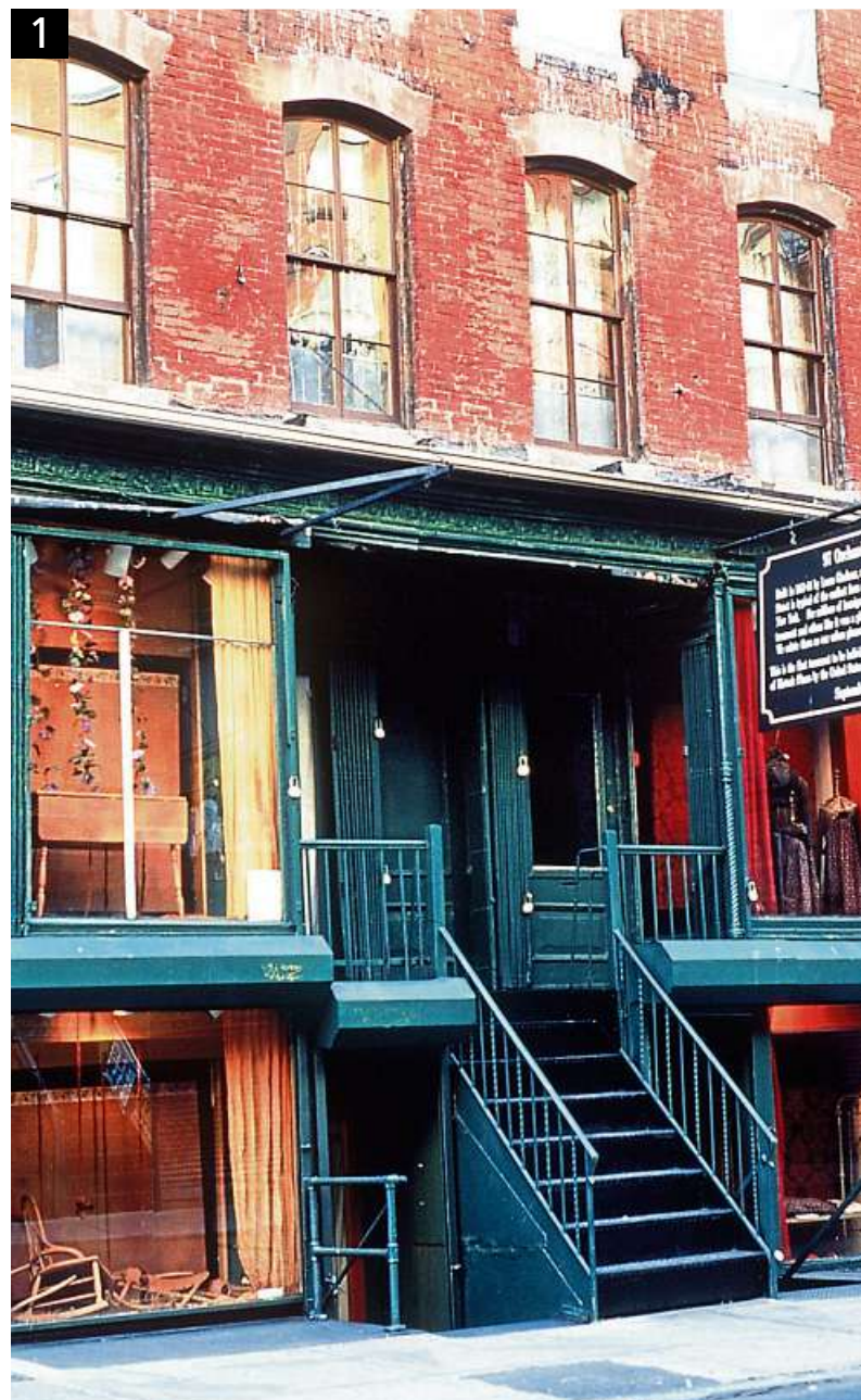
Blick auf das ehemalige Wohnhaus der Familie Gumpertz in der Orchard Street Nummer 97 in New York (Bild 1). Das schmale Haus erzählt einmalige Geschichten über das Leben der Einwanderer in den ersten großen Mietskasernen in „Kleindeutschland“, jenem Viertel im Osten Manhattans, wo bis Ende des 19. Jahrhunderts die meisten deutschen Immigranten eine neue Heimat fanden. Bild 3 zeigt die Küche der Familie Gumpertz, wie sie im Jahr 1870 eingerichtet war. Brigitte Doellgast (Bild 2), Bibliothekarin des Goethe-Instituts in New York, präsentiert die Website „German Traces“.
