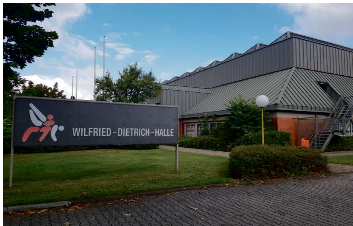
Ab Ende 2025 und Anfang 2026 kann voraussichtlich mit den Sanierungsarbeiten an der Wilfried-Dietrich-Halle begonnen werden.
