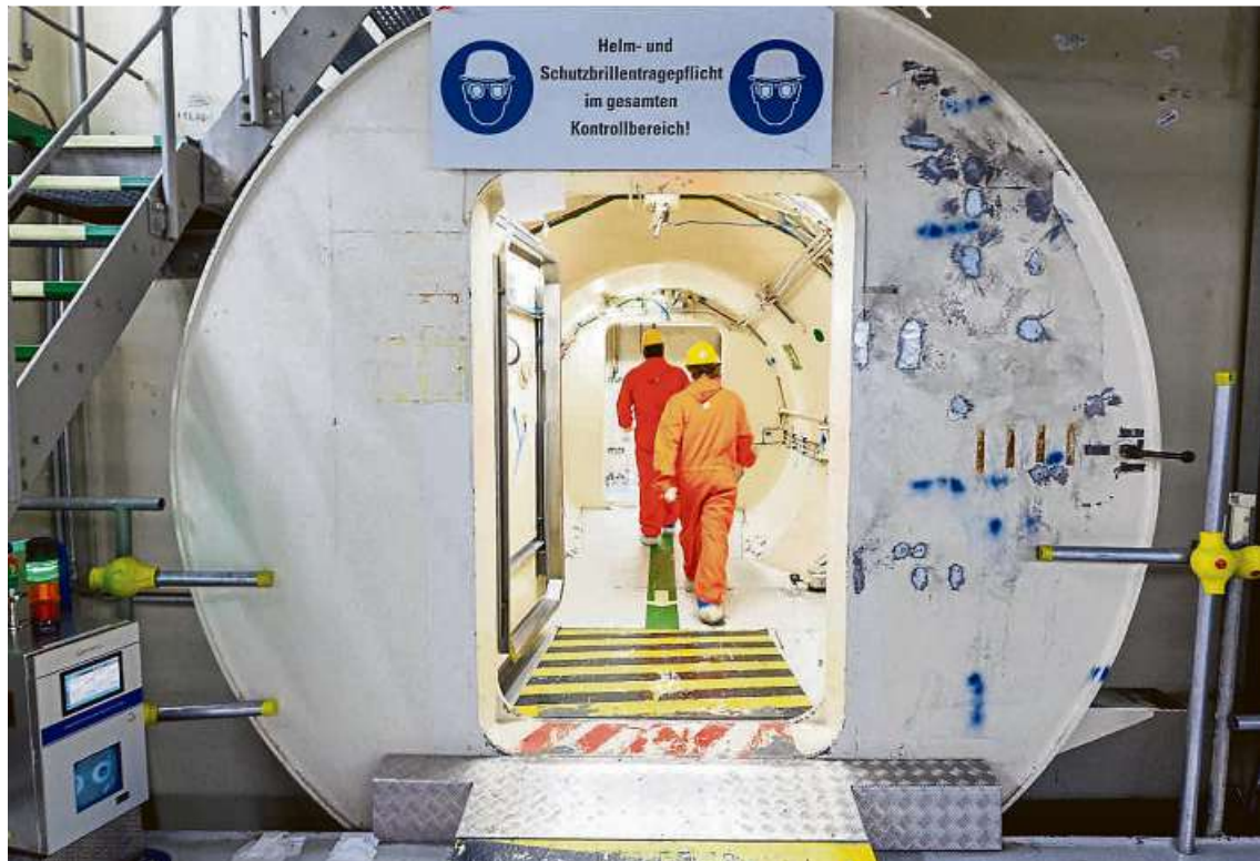
Nach dem für alle sichtbaren Abriss der ersten beiden Kühltürme ein Blick in das Innere des AKW Biblis: Hier wird bereits seit 2017 Stück für Stück zurückgebaut. Durch diese Schleuse gelangen die Arbeiter in den Block A. Fotos: Sascha Lotz (5) / dpa (1)
