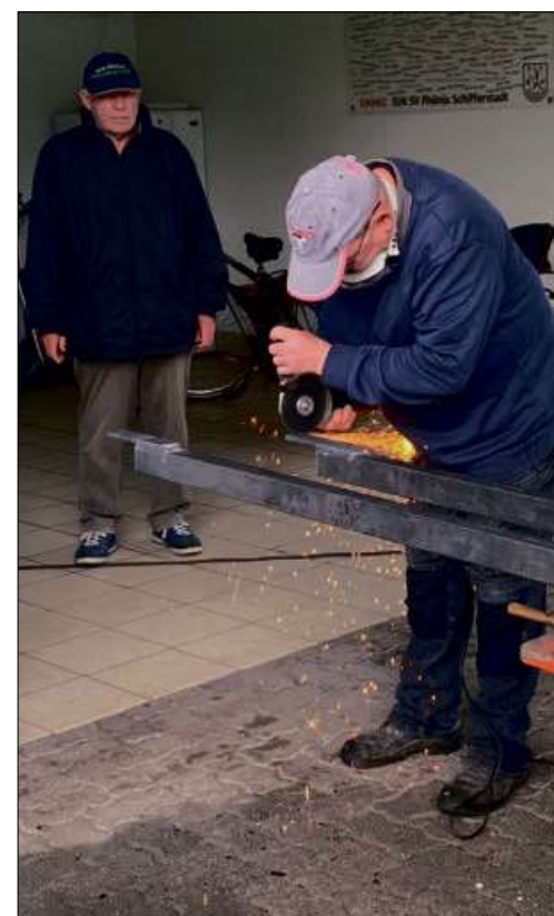
... oder mit der Flex abschleifen.
