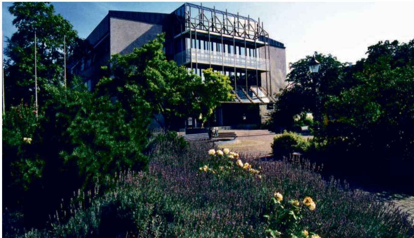
Das Rathaus muss mit neuen Fenstern ausgestattet werden - die vorgeschlagene Variante kommt nun deutlich teurer als der ursprüngliche Plan, nur das Glas auszutauschen.
