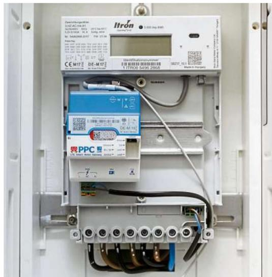
Im Schaltkasten hängt ein digitaler Stromzähler – dank Smart Meter kann er den Zählerstand automatisch übermitteln. Foto: dpa
