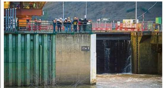
Provisorische Schleusentore müssen für jedes Schiff einzeln ein- und ausgebaut werden. Foto: dpa
