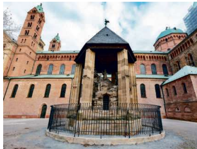
Abschluss der Arbeiten an der Umfassung des Ölbergs. Foto: Klaus Landry
