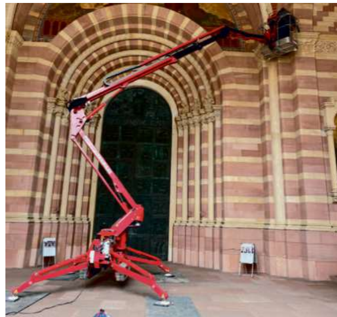
Restauratorische Reinigung der Vorhalle. Foto: Hedwig Drabik
