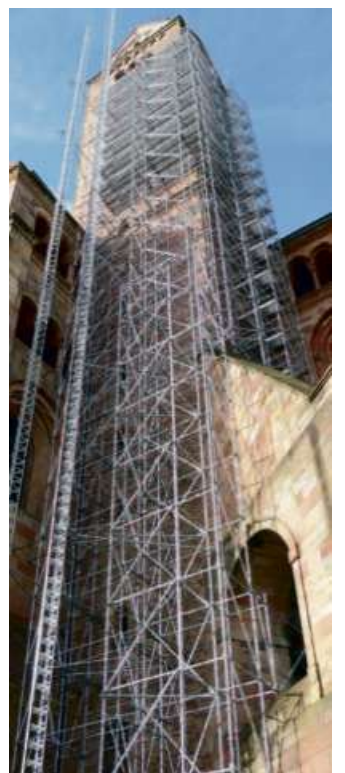
Gerüst am Nordturm. Foto: Hedwig Drabik
