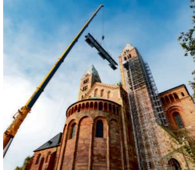
Gerüstbau am Südostturm. Foto: Klaus Landry
